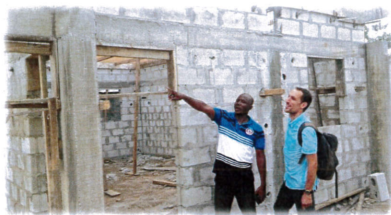
Suivi de chantier de la cantine
